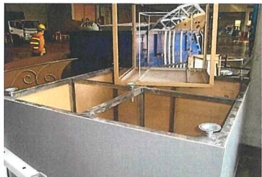
處理方法：在棄置前，必須對有關廢棄物作適當的預處理，將可重用的物料作（如金屬）拆解及回收，避免對垃圾焚化中心的運作造成影響。而可燃的廢棄物需切割成符合有關規定的尺寸（直徑不能超過 200 毫米）及長度（不能超過 3 米長），再運往垃圾焚化中心處理。
